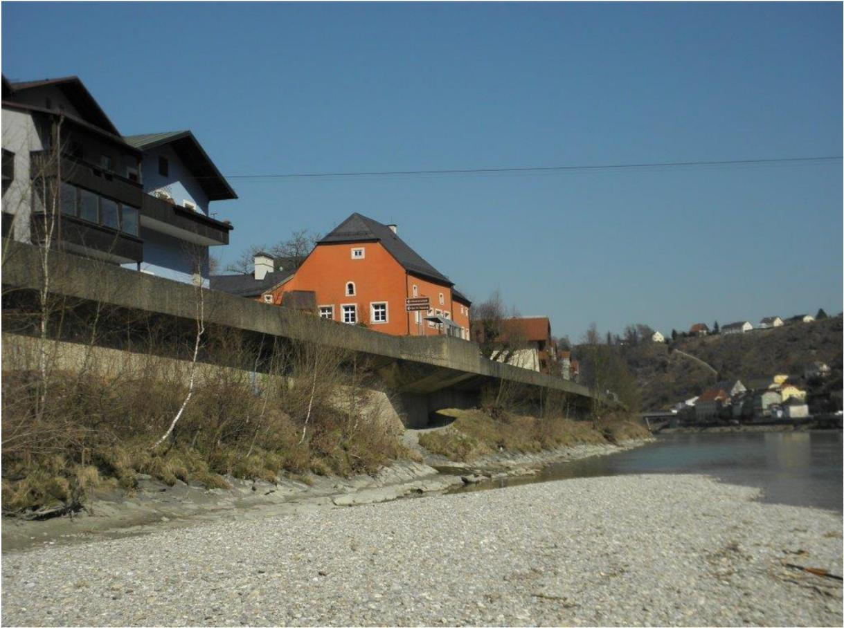
Die Vegetation und die Ablagerungen unterhalb der Ufermauer werden für Sanierungsarbeiten abgetragen.
